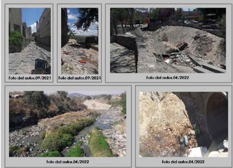
Figura 7. Fotografías de canales de desagüe pluvial y de aguas residuales.
