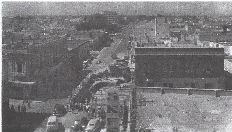
Figura 9. Imagen de la Avenida Juárez ensanchada a 25 metros y del desplazamiento del edificio de la Compañía Telefónica y Telegráfica Mexicana, labor realizada entre el 24 y el 28 de octubre de 1950. Sobre el frente no rebanado se percibe el dominio de fincas históricas y resalta por su verticalidad el “Edificio Profesional” construido por el ingeniero Jorge Matute Remus en 1947.
