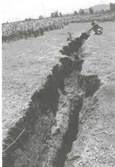
Fig. 7 Grieta formada en 2004, la cual se reactivó en junio del 2006
